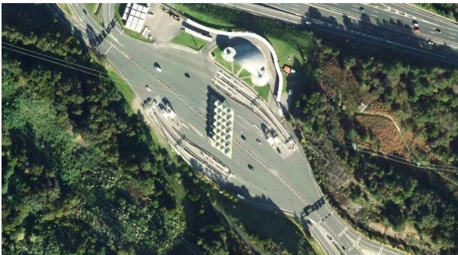
PEAJE TUNELES DE ARTXANDA (ESPAÑA). 18 CARRILES. KINEO INGENIERIA. ALEJANDRO MONTERO GIL, GERENTE DEL AREA DE PEAJE DE KINEO INGENIERIA DE TRÁFICO.
